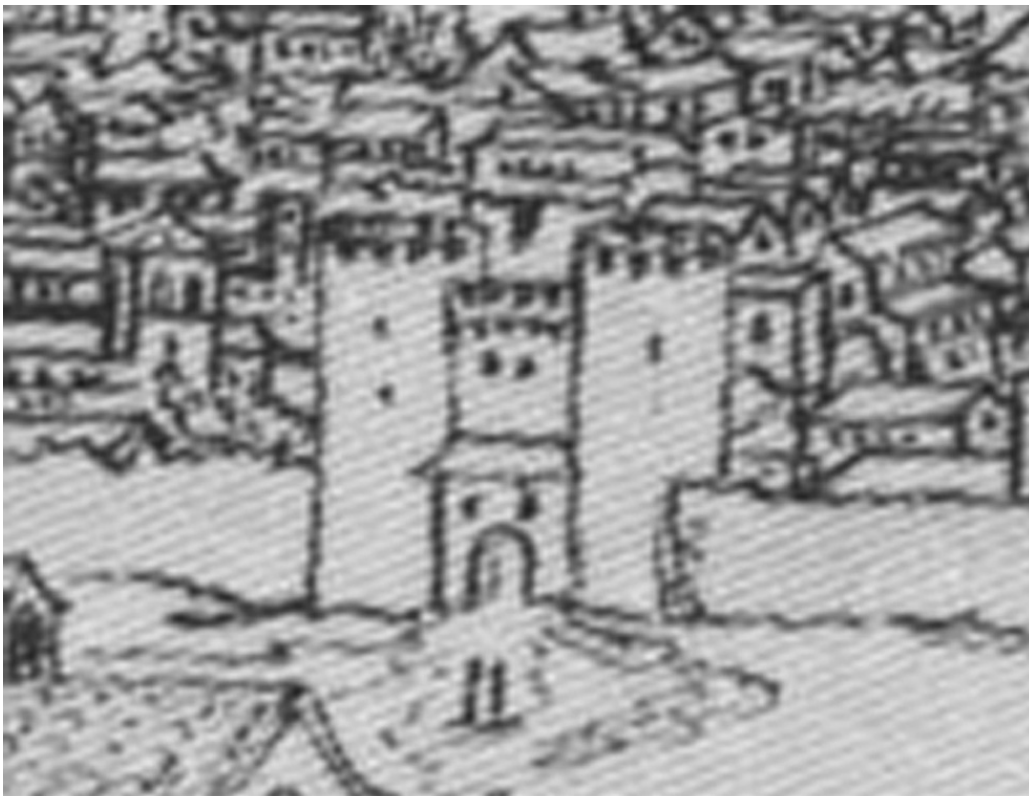
15_ Puerta de Valladolid de la muralla, Vista de 1570. Wyngaerde. "La estructura urbana de Medina del Campo" A. Sánchez del Barrio
